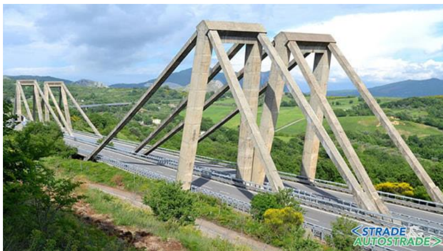
Figure 2.3.4. Carpineto Viaduct (ID-8). Stays overview ( https://www.stradeeautostrade.it/ponti-e-viadotti/il-viadotto-strallato-carpineto-i-2/ )
